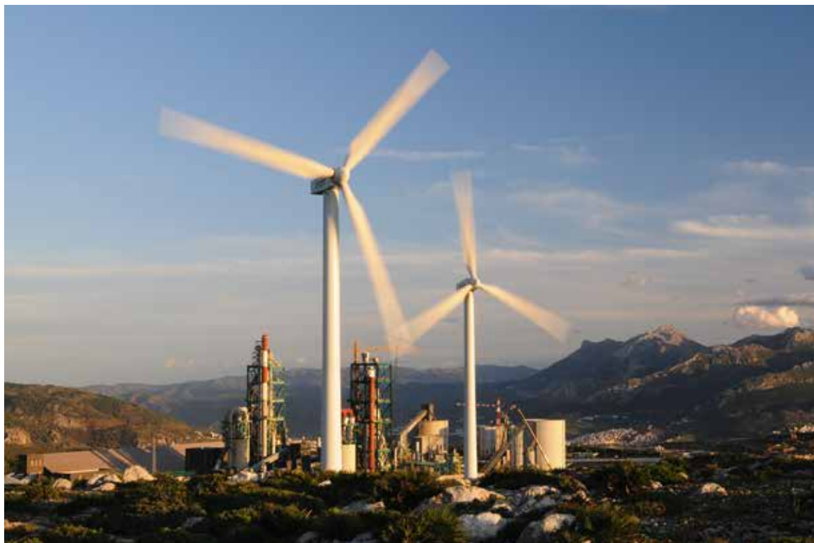
Usine LafargeHolcim, Tétouan
